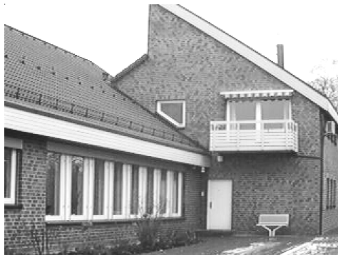
Abbildung 12: Gebäude mit Wärmebrücken (IEMB)
